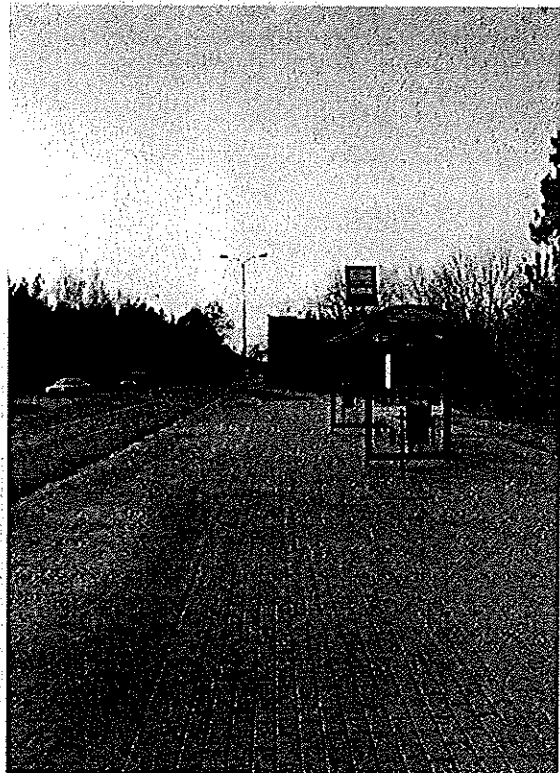
Zatoka autobusowa i wiatka przystankowa na ul. Grunwaldzkiej
