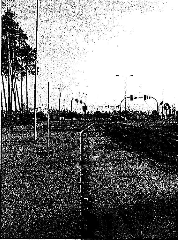
Zatoka autobusowa na ul. Deszczowej
