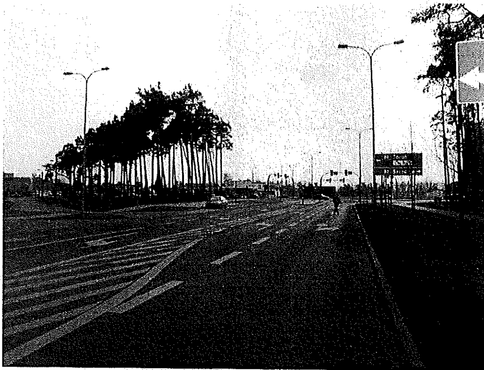
Odcinek nowowbudowanej ul. Deszczowej
